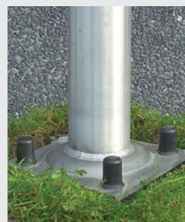
Assure la protection des écrous et filets des tiges de scellement en évitant l'oxydation.
