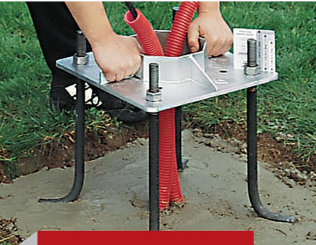
Positionnement précis des 4 tiges de scellement et à la bonne hauteur (jauge livrée avec Nivoscel).
